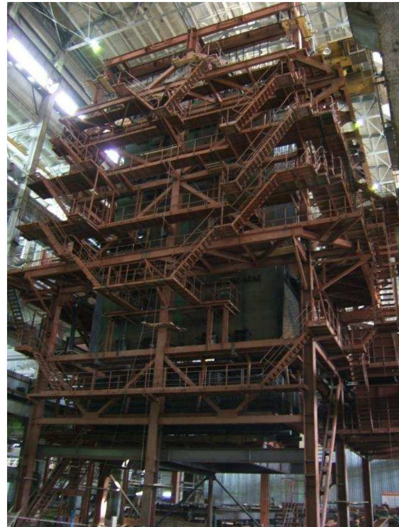
Котел Е-500 в стадии монтажа
