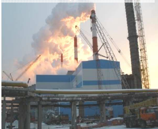
Монтаж дымовой трубы (декабрь 2009)
